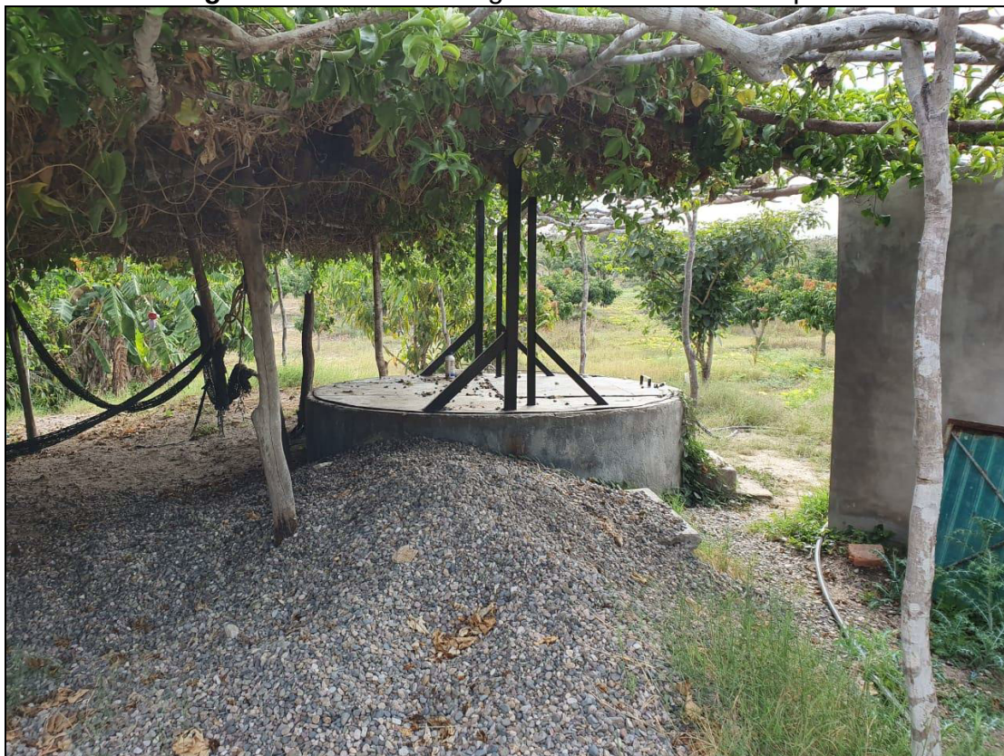
Fotografía II.3- Pozo de agua ubicado dentro del predio
