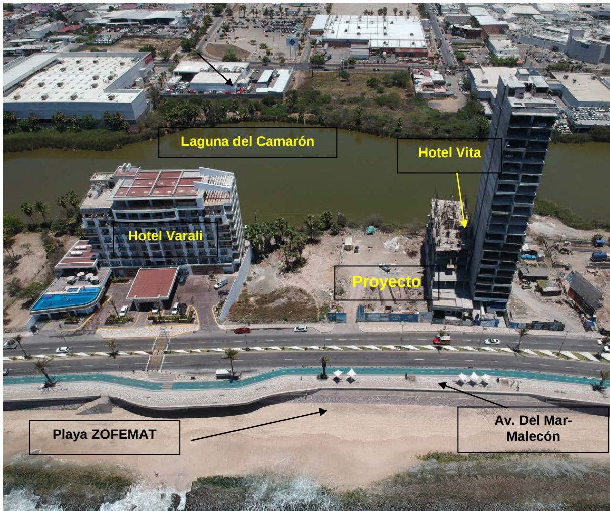
Fotografía II.4. Colindancias del Proyecto con vista aérea tomada con DRON.
