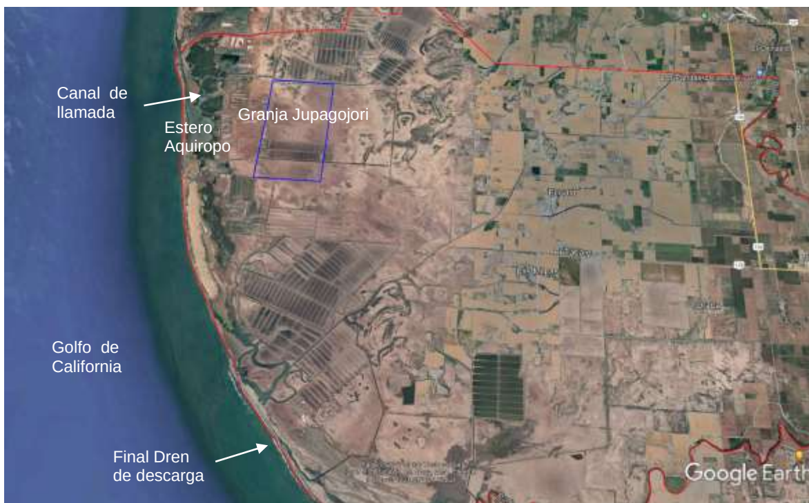
Vista del sitio del proyecto Granja Camaronicola Jupagojori , así como del canal de llamada y dren colector perimetral de descarga de agua.
