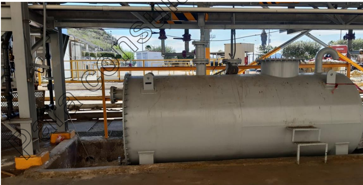
Figura II.6.- Tanque T-18 donde se colecta el H 2 SO 4 resultante de las purgas de las líneas de descarga. El ácido aquí colectado es enviado al tanque T-7.
