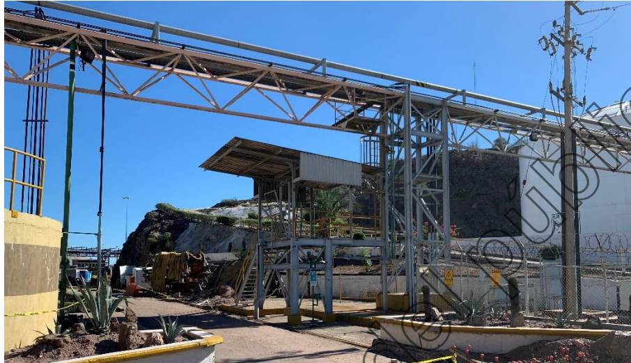
Figura II.7.- Rack de tuberías que conducen el H_2SO_4 de la plataforma de descarga al Tanque Transferencia (T-7) que se aprecia en blanco a la derecha.
