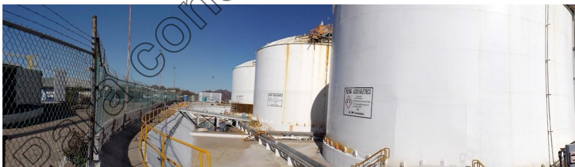
Figura II.9.- Dos imágenes que muestran los tanques T-8, T-9 y T-10. Abajo dique de contención de derrames. Atrás de estos tanques se encuentra el tanque T-11.
