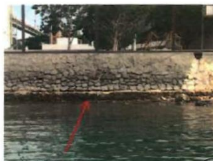
Plataforma del pateo del talud
