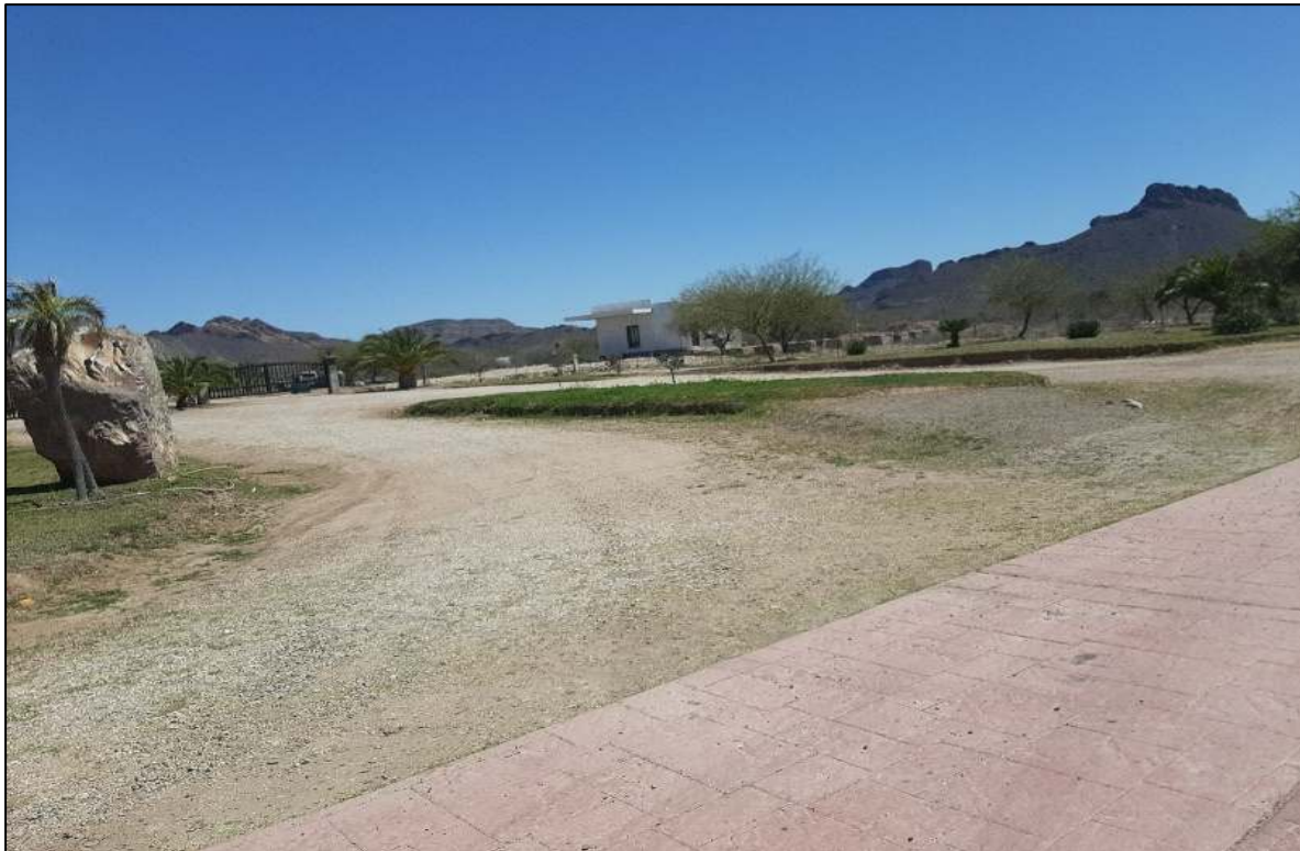
Figura 22. En el área del proyecto se encuentran estructuras de concreto y como se observa en la imagen la zona se encuentra en su mayor parte desprovista de vegetación.
