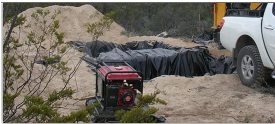
Ilustración 19 Fosas o cárcamos de recirculación de lodos y su forma de impermeabilización (foto de archivo).
