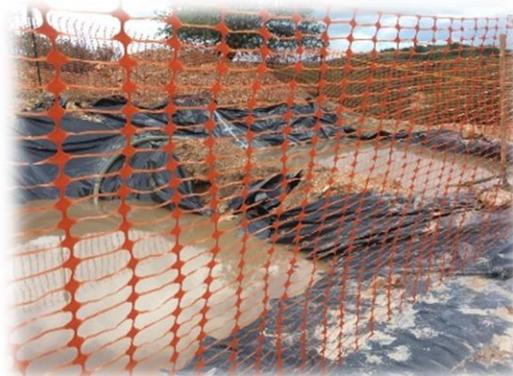
Imagen 10 Fosas o cárcamos de recirculación de lodos y su forma de impermeabilización
