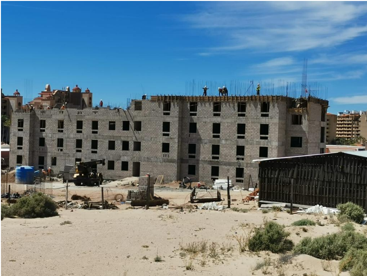
Fig. II.4. Fotografías de las obras realizadas.
