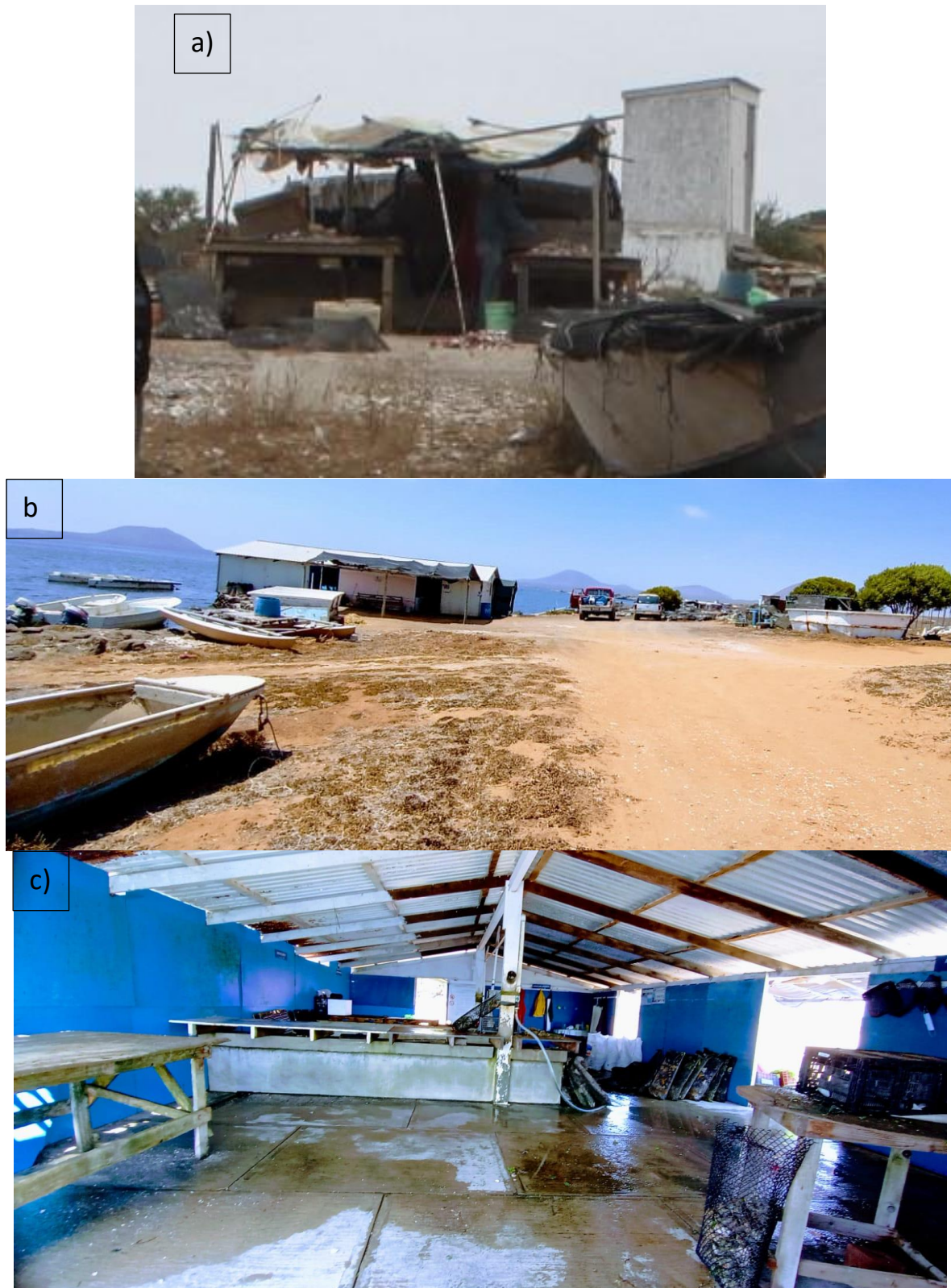
Foto 3. Infraestructura y equipamiento en ZOFEMAT terrestre concesionada: a) Inicio de concesión 2001y; b) y c) En 2021.
