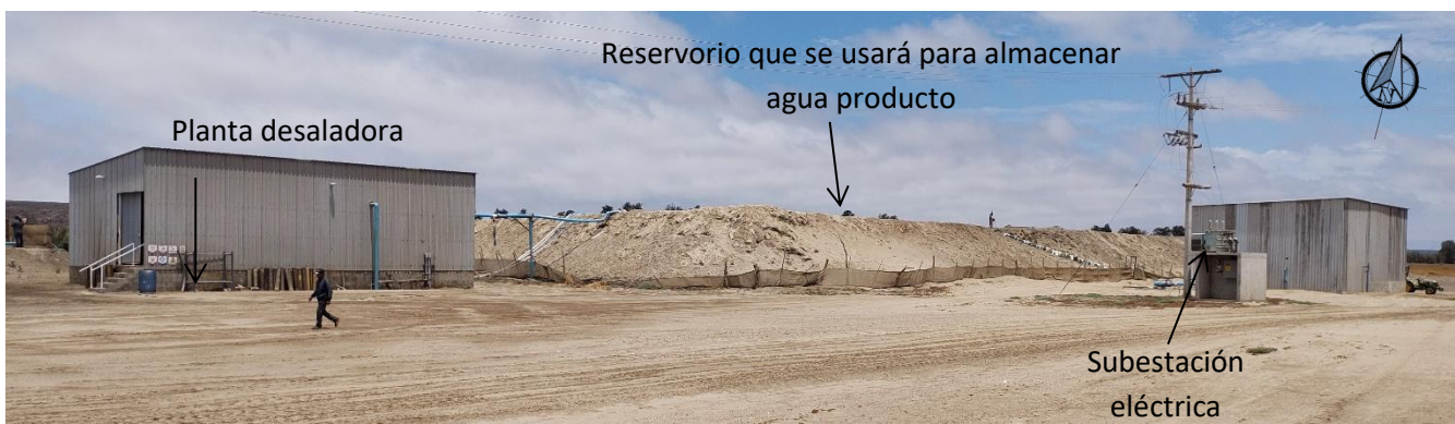
Foto 4. Reservorio que en la actualidad se utiliza para almacenar agua de pozos que mantienen una buena calidad. Cuando esté operando la planta desaladora será el reservorio del agua producto.
