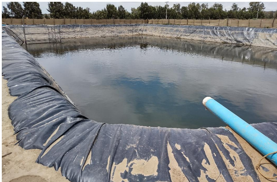
Foto 6. Reservorio que se utiliza para almacenar agua rechazo que se genera cuando por momentos se enciende la desaladora para evitar daños a las membranas. En la etapa de operación este reservorio se utilizará para el agua de pozos sin tratar.
