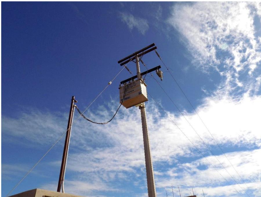
**Foto 5.** Subestación eléctrica de 75 KVA.
