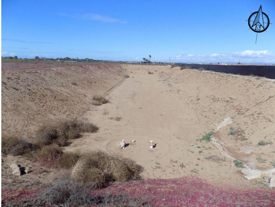
**Foto 3.** Vista actual del reservorio que será utilizado para el agua de los pozos. Para hacerlo funcional se alisarán y compactarán los bordos y la parte interna se cubrirá de plástico.
