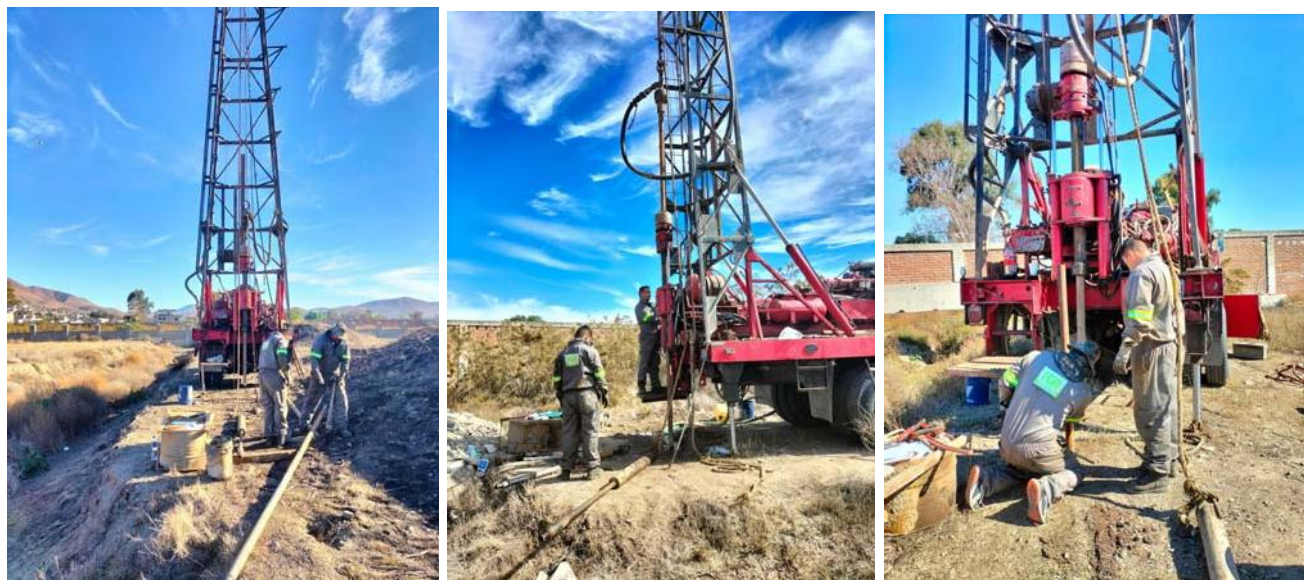
Figura 3.2. Vista de equipo de perforación longyear 34
