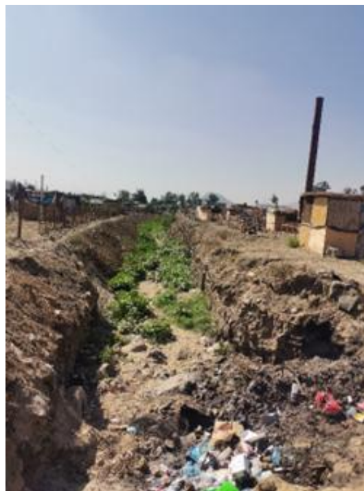
Cauce actual con evidencia de residuos y gran cantidad de sedimentos.
