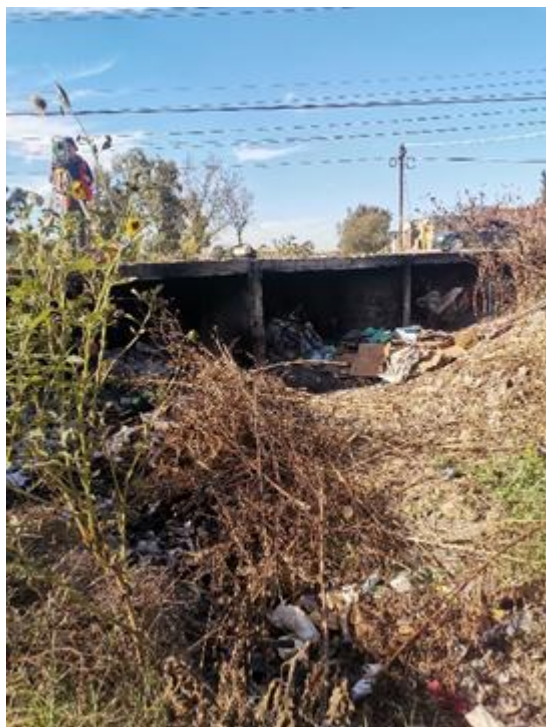
Sitio de intersección del actual arroyo con la obra del Proyecto (Puente Abedul)
