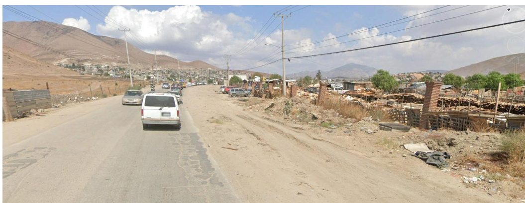
Figura 44. Vista general al centro de la microcuenca que conforma el SA.
