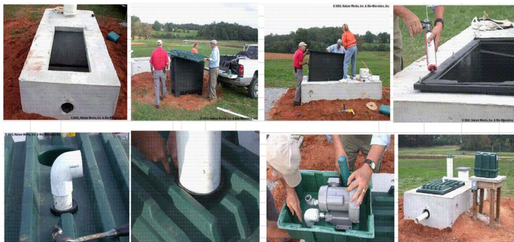
Figura 6. Imágenes y esquema de biodigestor
