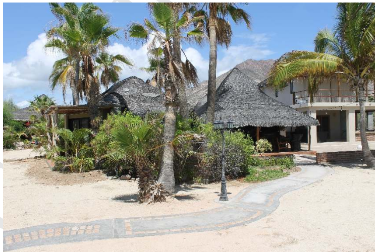
Figura 18. Viviendas tipo villa residencial que serán beneficiadas con la operación de la planta desaladora.
