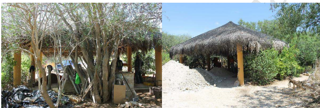
Figura 5. Acercamiento a la palapa, así como a la base de la misma.
