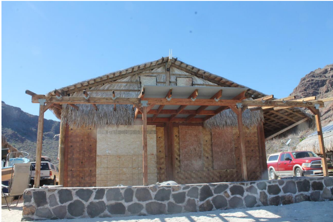
A2. Vista de la infraestructura del proyecto
