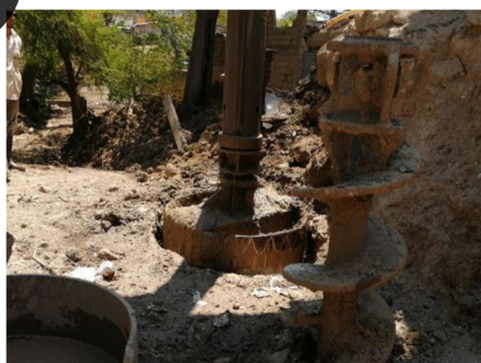
Imagen II.4. Vista de los procesos de ubicación de pilotes, perforación y habilitado de acero de refuerzo.
