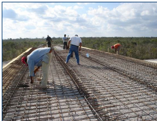
Imagen II.8. Construcción de losa
