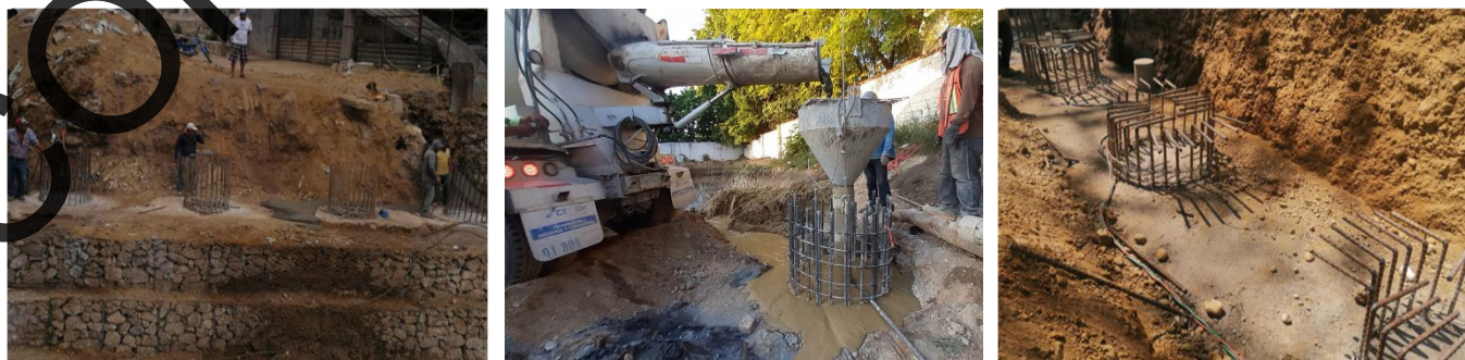
Imagen II.5. Colado de pilotes, plantilla para posterior colocación de acero de refuerzo y colado de cabezal.
