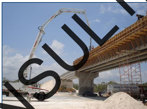
Imagen II.9. Proceso grafico de la construcción de guarniciones y parapetos.
