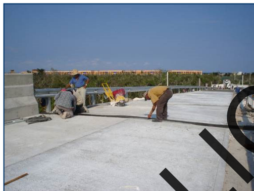
Imagen II.10. Proceso gráfico de la construcción de las juntas de dilatación
