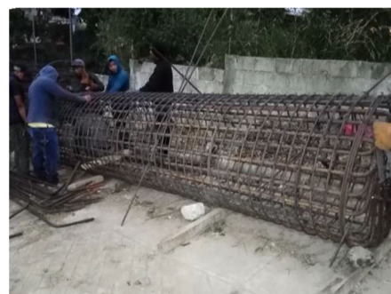
Imagen II.4. Vista de los procesos de ubicación de pilotes, perforación y habilitado de acero de refuerzo.
