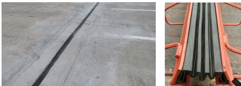
Figura II.14. Junta MexT-50 para su colocación en los accesos del puente.
