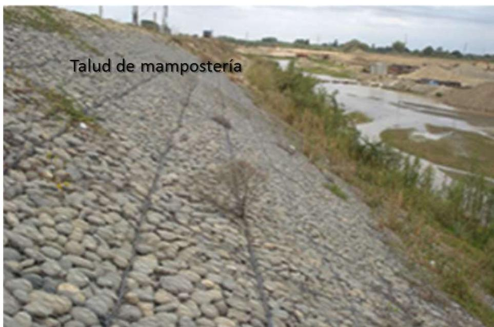
Para la edificación de esta obra se requiere de materiales de construcción como cemento, grava y arena que al mezclarse con agua forman una pasta resistente para pegar la piedra bruta o balón.
