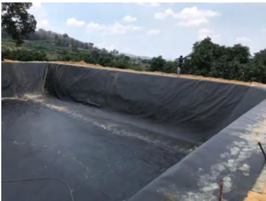
Figura III-29. Formación de una pileta a base de geomembrana
