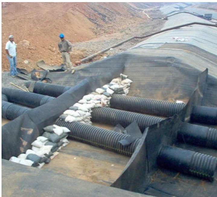
Figura II-12. Instalación de tuberías ADS para el manejo de excedencias
