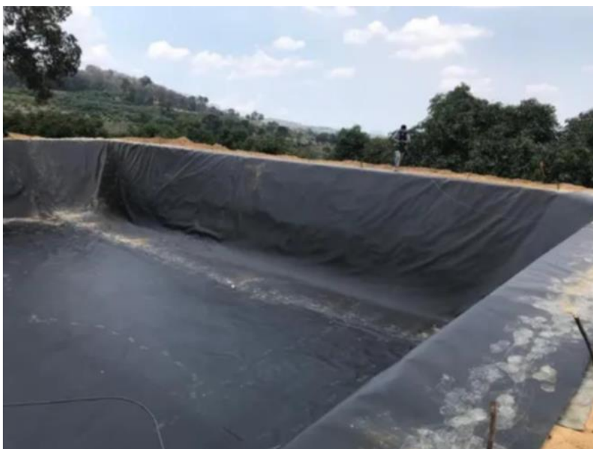
Figura III-20. Formación de una pileta a base de geomembrana
