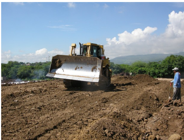
Figura II-3. Movimiento de tierras
