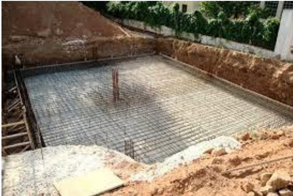
Ilustración 7. Imagen representativa base de concreto armado
