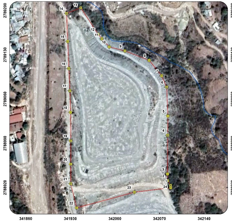
Figura II-2. Ubicación física del polígono del depósito de jales
