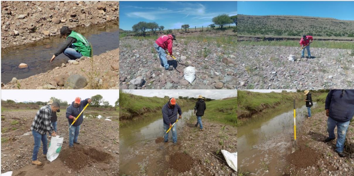
Figura IV-41. Excavaciones en el sitio para verificar profundidad y disponibilidad de material
