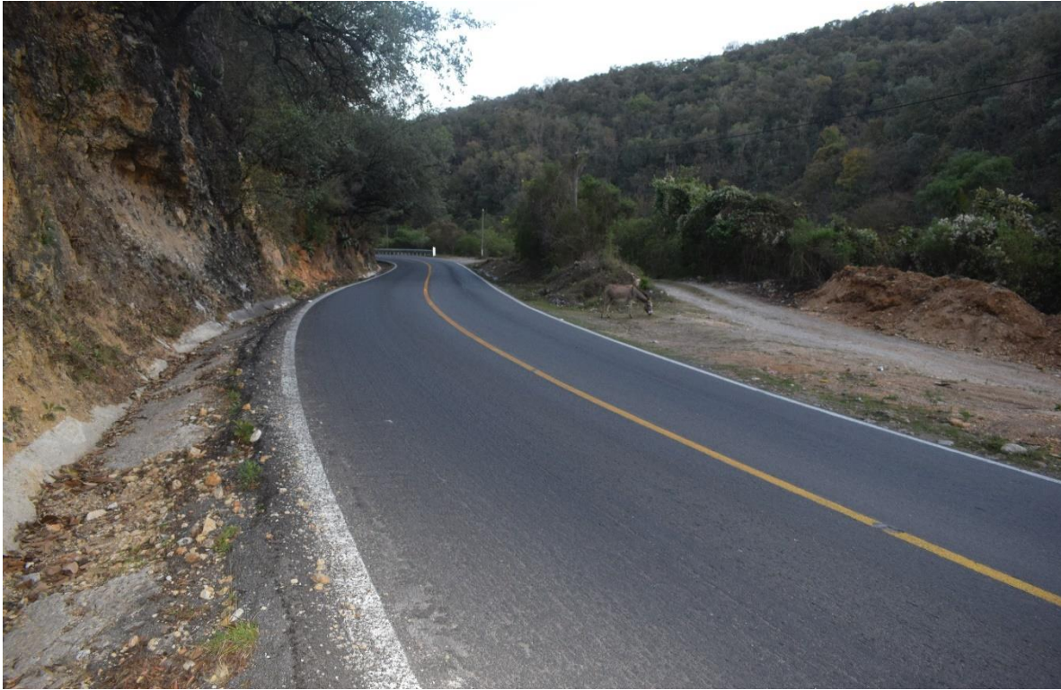
Foto 1. Vía de acceso a través de carretera federal 93 rumbo a Chilapa de Álvarez.
