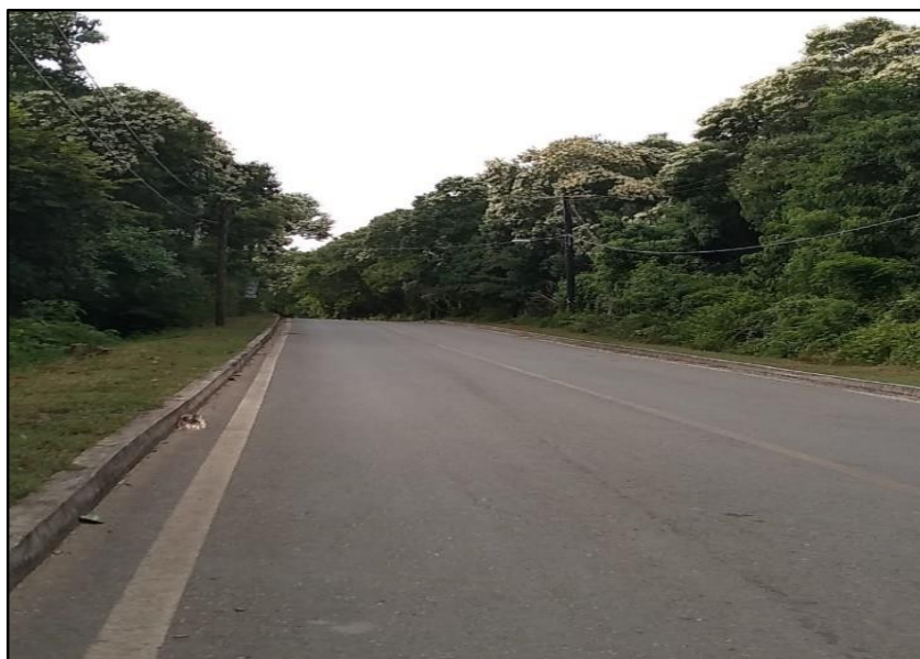
Ilustración II.1.6.1. Acceso del proyecto “Mariposas”.
