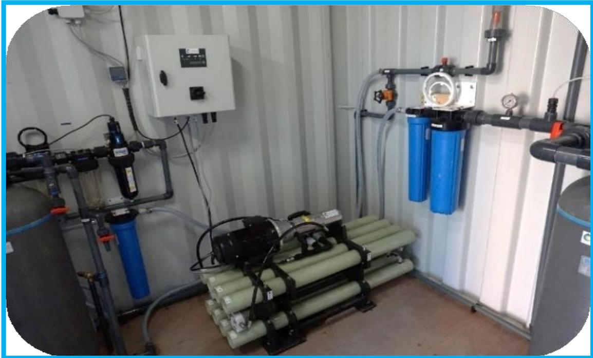
Imagen de los componentes del sistema de Osmosis Inversa.
