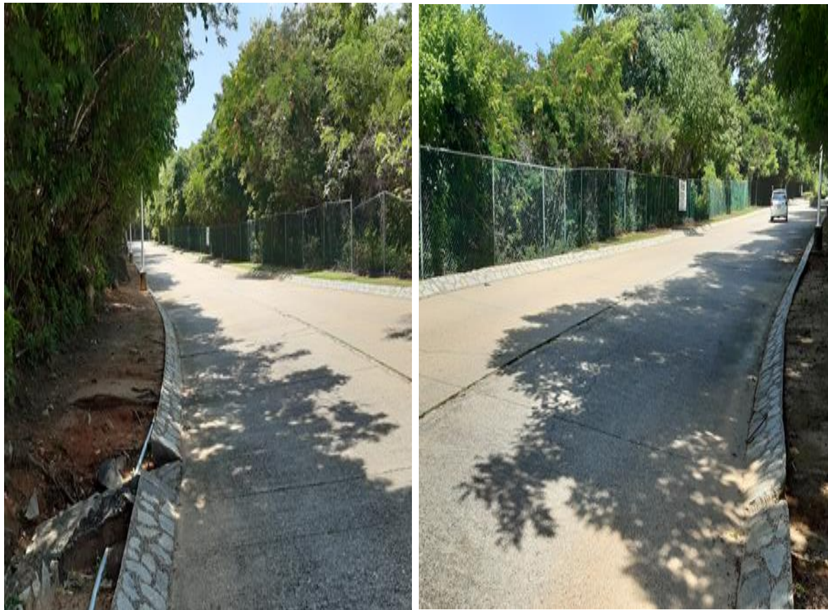
Fotografía 1.- Vista de la Bulevard Cabo Marques, sobre el lote 10 A y 10 B.
