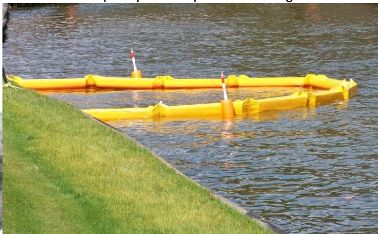
Imagen 14. Vista representativa de ejemplo de la barrera de turbidez que se podrá colocar en las aguas dârsenas del proyecto del restaurante.
