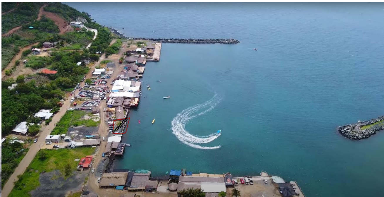
Imagen 8. Vista aérea tipo frontal del predio con dirección al noroeste en donde se puede observar la vialidad interna, así como las construcciones similares desarrolladas sobre la topografía plana existente.
