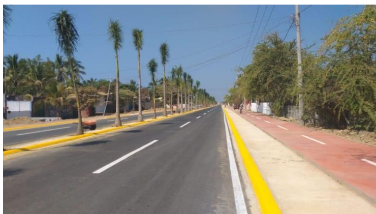
Imagen 3 Vías de acceso
