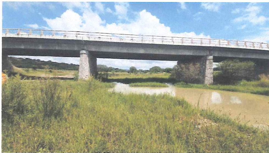
Figura 7. Vista general del puente Juiquinaque.
