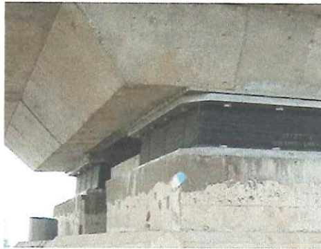
Figura. 17. Neoprenos para puente vehicular
