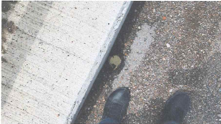
Figura. 15. Drenes en buen estado.
