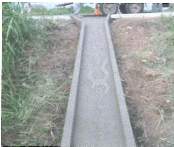
Figura. 19. Ejemplo de lavadero de carretera.
