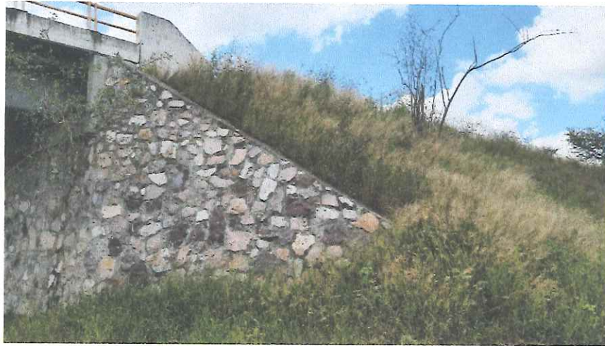
Figura. 10. Alero y cabezal de concreto en buenas condiciones.
