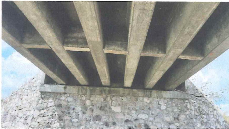
Figura. 8. Vista de la sub estructura con traveses y cabezal de concreto armado, sobre estribo de mampostería, todo en buenas condiciones.
