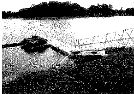
ILUSTRACIÓN 5- RAMPA Y ANCLAJE DEL MUELLE FLOTANTE (MATERIALES CANDOCK).
