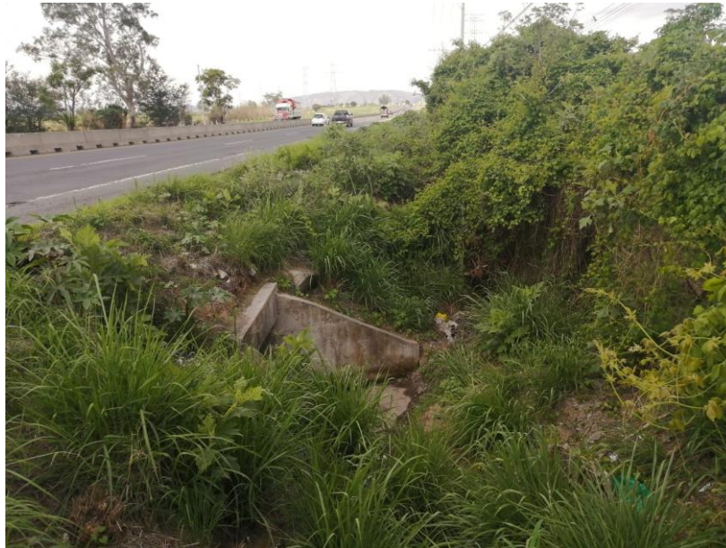
Imagen 9. Punto del arroyo que cruza con la calle en donde se realizará la descarga
