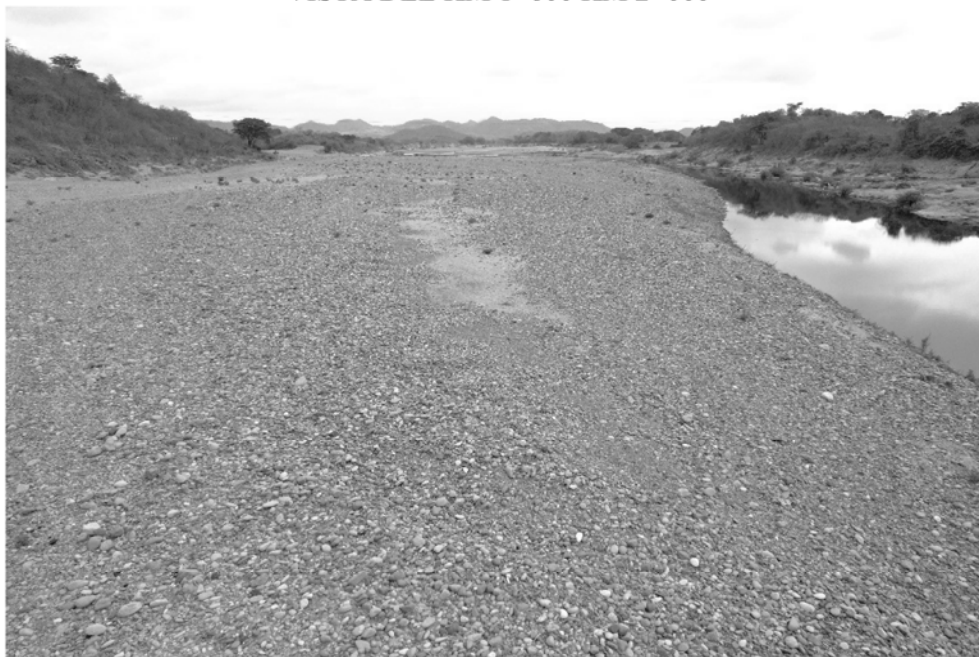
VISTA DEL KM 1+600 KM 2+000
