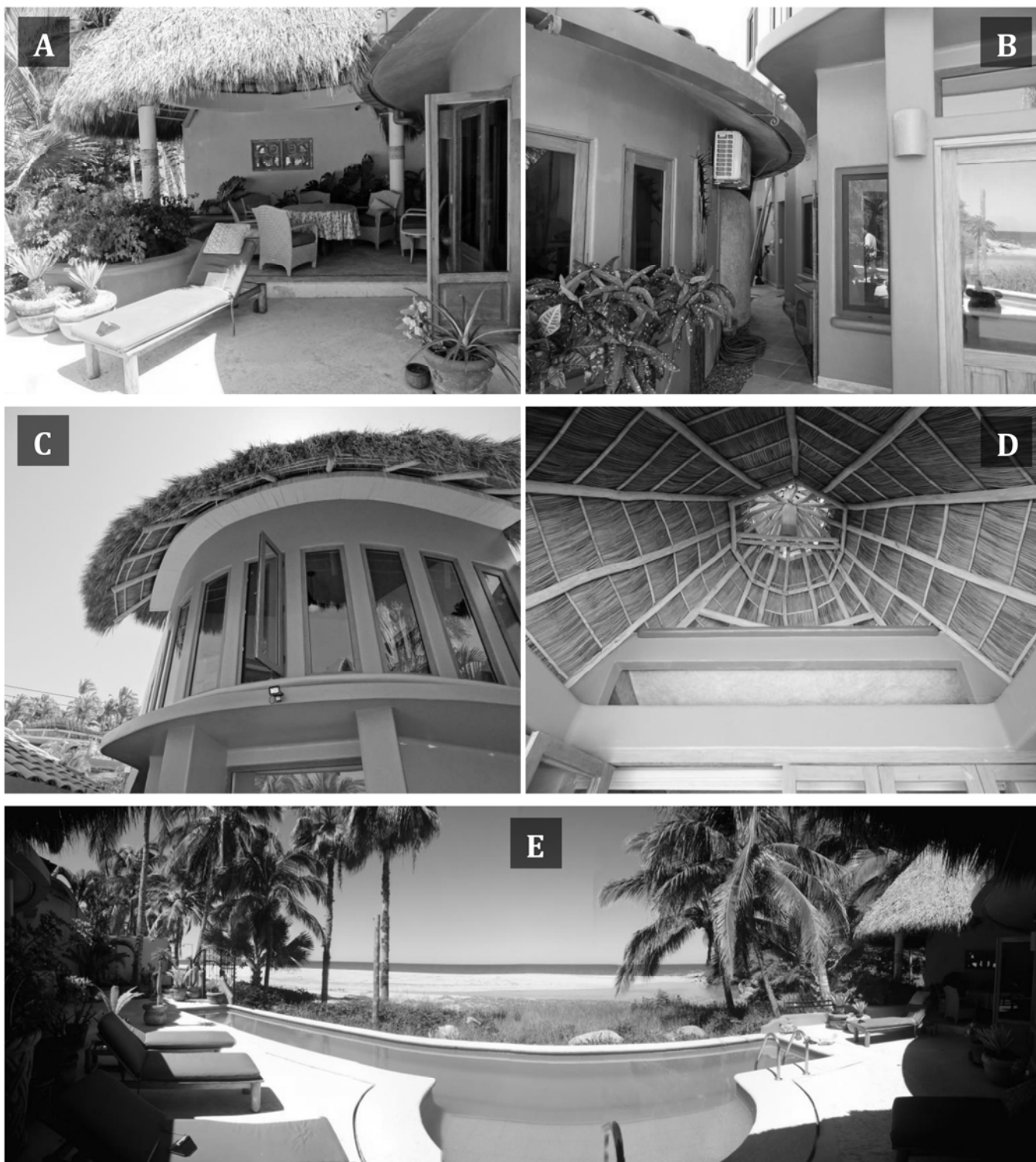
Figura II-8. Casa Calabaza: (A) Palapa hecha con estructura de concreto y madera de la región con techo de palma y muro lateral. (B) Pasillo entre la casa principal y el edificio anexo. (C) Fachada posterior del edificio anexo, planta alta. (D) Estructura de los techos de palapa. (E) Vista panorámica de la terraza (asoleadero, alberca, muro de protección y palapa).
