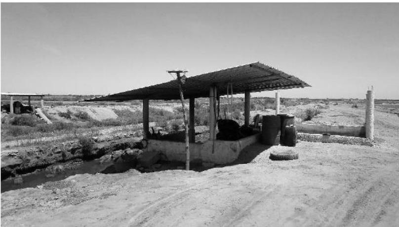
Cárcamo de bombeo de la granja con tejaban de mampostería y techo de láminas galvanizada sobre el canal de llamada.
