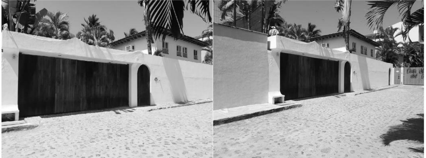
Figura II-10. Acceso principal de la Casa Habitación No. 3 por la Privada Benito Juárez.
