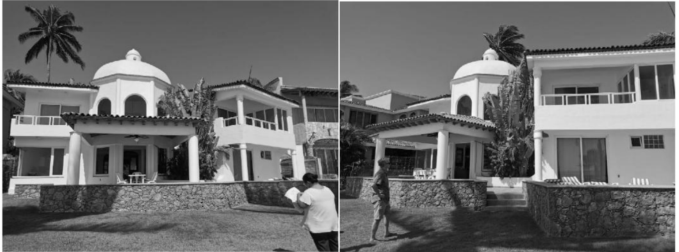
Figura II-12. Fachada posterior de la casa dos con vista al mar, en donde se puede observar el muro de contención sobre el cual se localiza la terraza sujeta a acciones de remodelación para generar los espacios de Sala de Estar T. V. asador (BBQ) y terraza.
