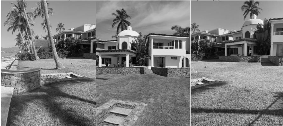
Figura II-13. Muros de contención hecho de mampostería ubicados en límite sur del terreno.
