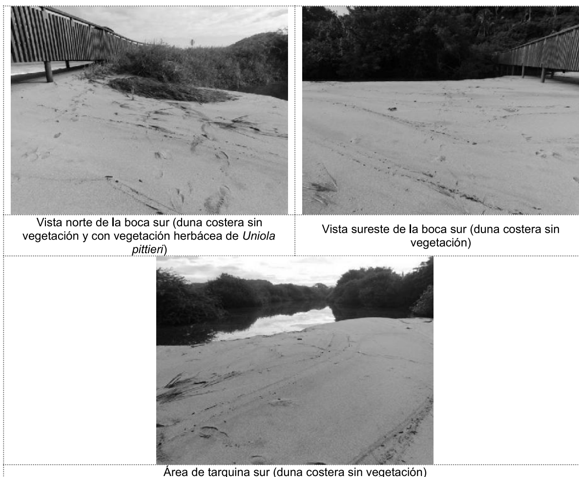
Ilustración 61. Evidencia fotográfica del área del Proyecto.
