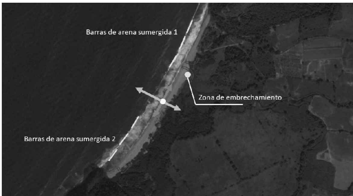
Ilustración 56. Evidencia de una barra sumergida producto de temporales invernales y transporte de sedimento longitudinal (flechas azules) y transversal (flechas verdes) a la línea de costa. Foto obtenida de Google Earth con fecha de 24/01/2014.
