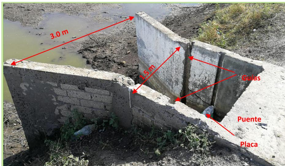
Imagen II.13 Compuerta de drenado
