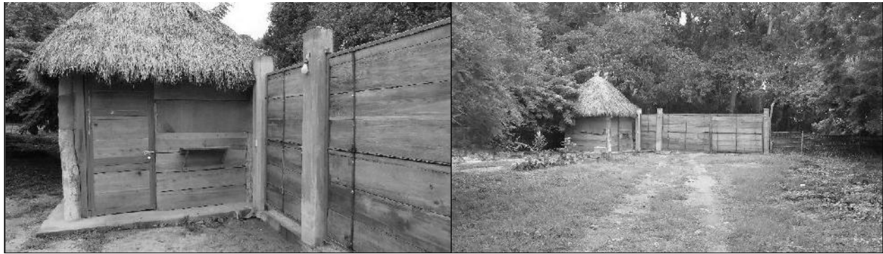
Fotografías que muestran el portón y caseta de vigilancia
