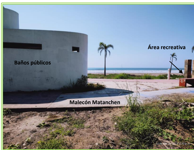
Imagen III.1 Malecón Matanchén colindante al polígono del proyecto.
