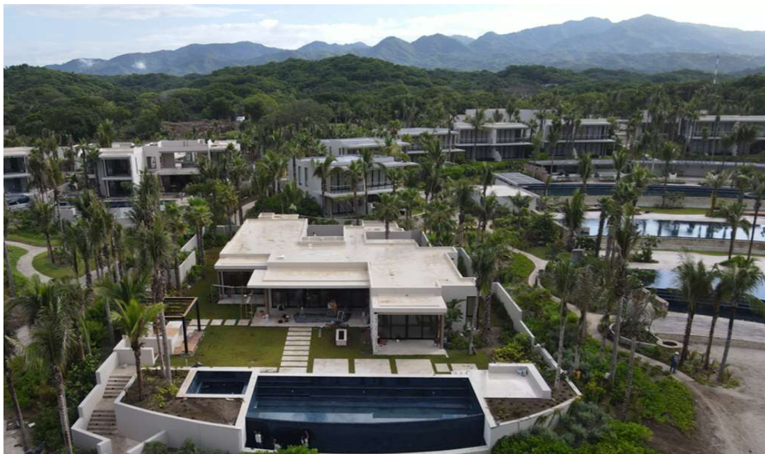
FIGURA II. 4 VISTA DE LA PARTE FRONTAL Y ALBERCA DEL HOTEL
