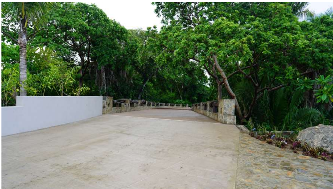
FIGURA II. 7 PUENTE Y VIALIDAD INTERNA DEL HOTEL
