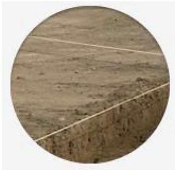
**Levantado de encofrado perdido:** Una vez completada la excavación del terreno, se procederá a levantar el encofrado perdido de ladrillo, dando la forma a la futura piscina.
