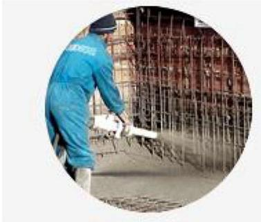
**Acabados del hormigón:** Cuando el equipo que se ha encargado de proyectar el hormigón termina su trabajo, otros operarios se encargarán de alisar la superficie obtenida, limpiando las salidas de las tuberías y rellenando las pequeñas hendiduras que pudieran existir.
