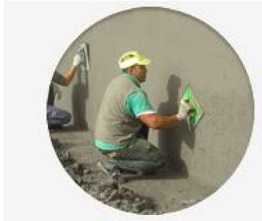
**Coronación:** Aquí comienza la parte estética de la piscina, cuidando de los acabados, la forma de las juntas y el nivelado de la corona sean ajustados con precisión. La coronación puede realizarse en distintos tipos de piedra e incluso puede realizarse un acabado final en madera tratada.
