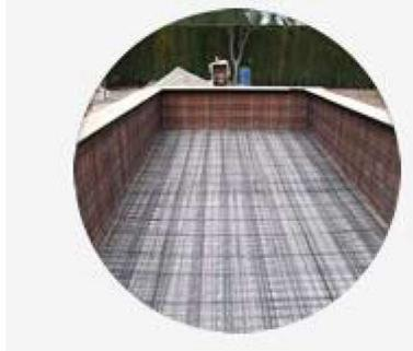
**Vaciado de hormigón proyectado:** El proceso del vaciado consiste en proyectar hormigón a alta presión, este método proporciona una perfecta adherencia con la armadura de acero, al utilizar menos agua se mejoran las condiciones de resistencia e impermeabilidad del vaso. La presión evita la formación de bolsas de aire.
