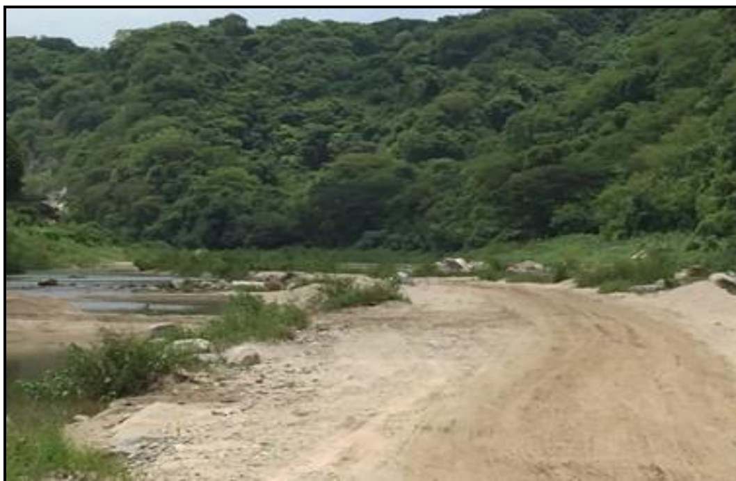
Fotografía 13. Condiciones actuales del camino de acceso a la zona de aprovechamiento del material pétreo.
