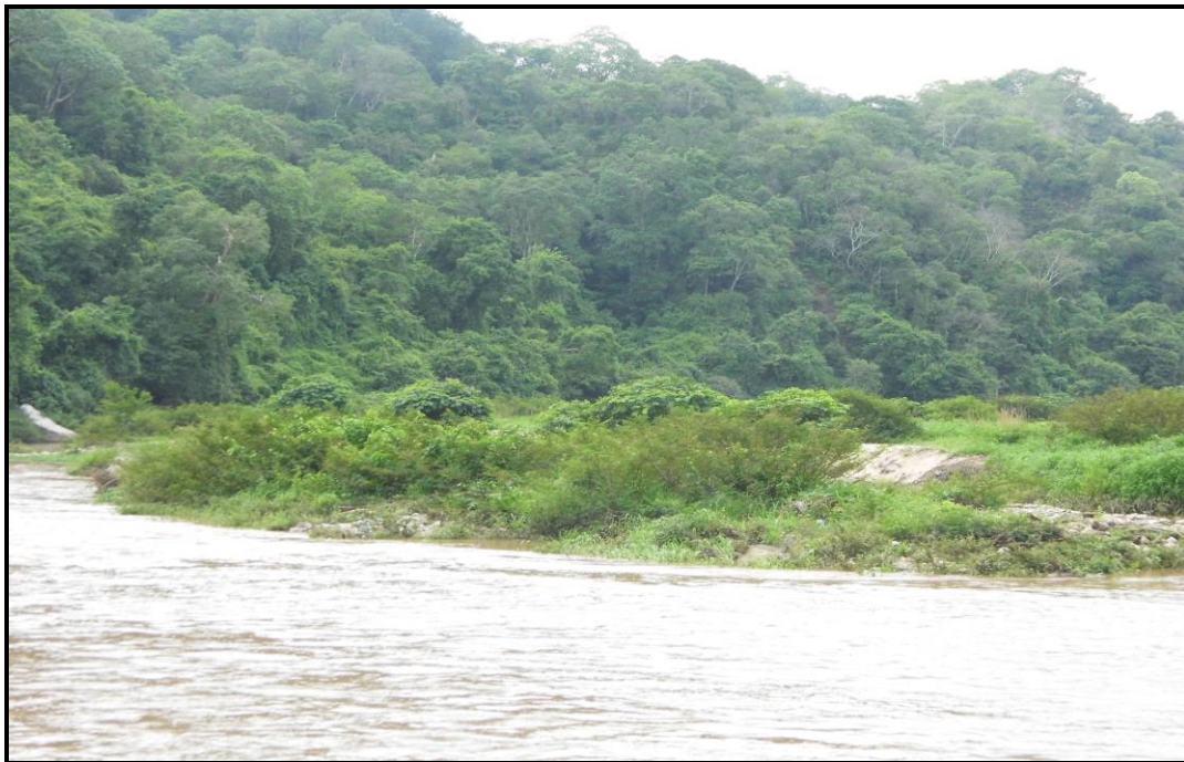
Fotografía 5. Nótese los bordos de afectación aguas abajo del sitio del proyecto, lo que genera un desvío del río y por consecuencia modificación de su cauce.
