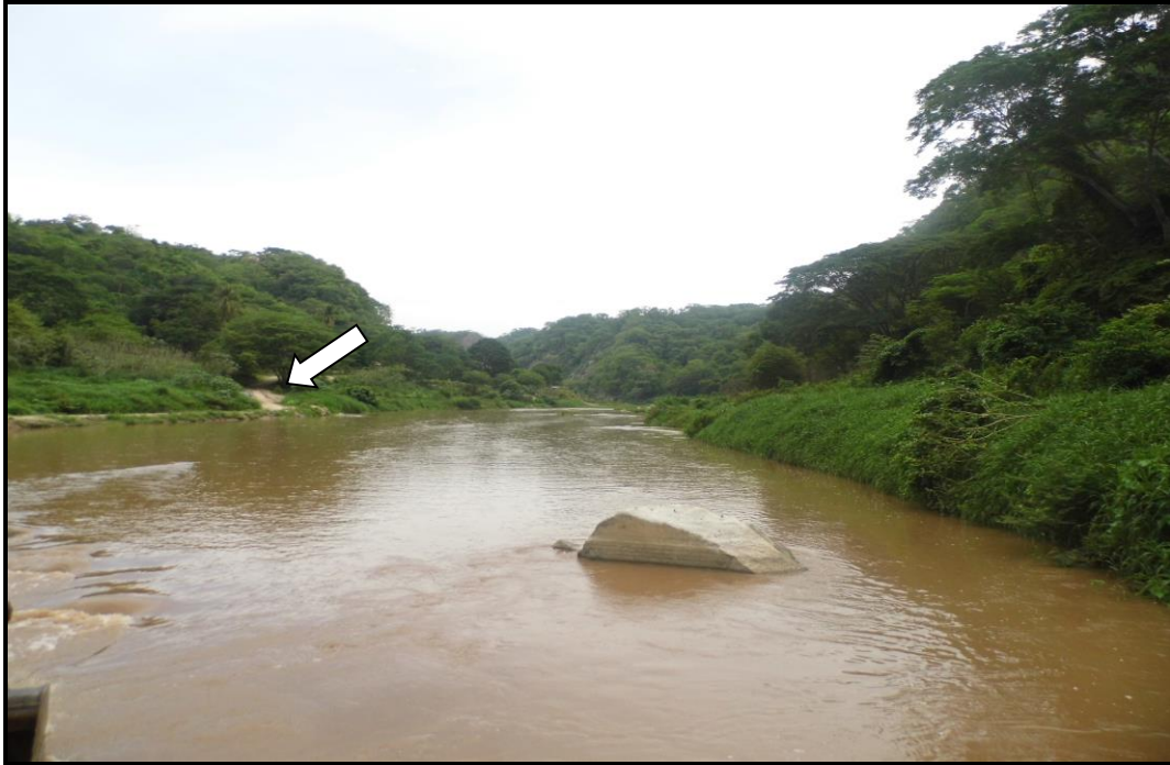
Fotografía 3. Existe un camino de acceso al cauce del río Las Arenas en el sitio propuesto como banco de aprovechamiento de material pétreo en greña, por lo que no será necesaria la apertura de un nuevo camino.
