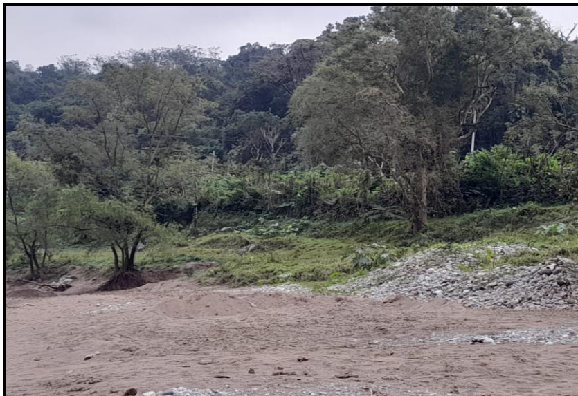
Fotografía 2. El sitio del proyecto colinda con terrenos destinados a la agricultura debido a la cercanía del cauce del río, donde en épocas de lluvias estos terrenos zona afectados por la crecienta del mismo.
