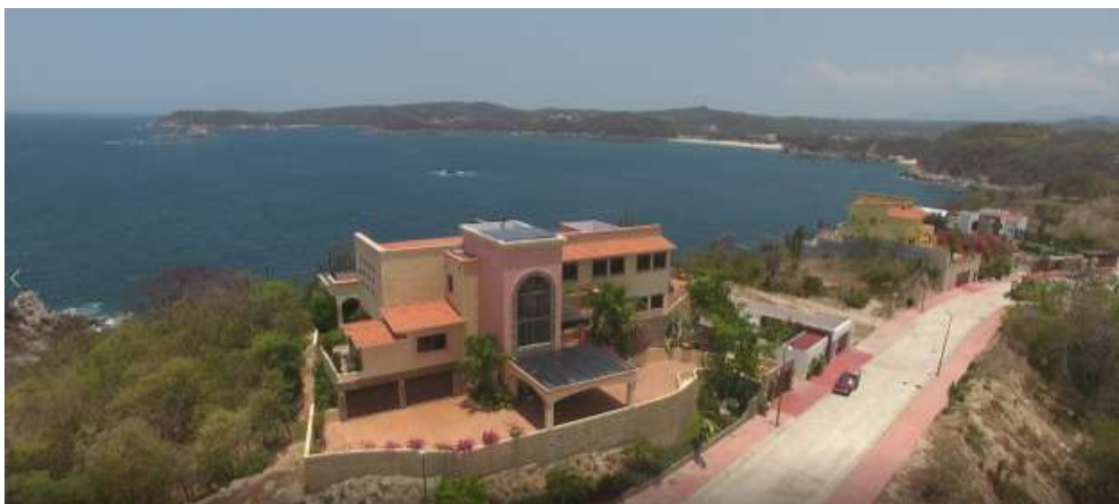
Calle de acceso al predio y construcciones colindantes
