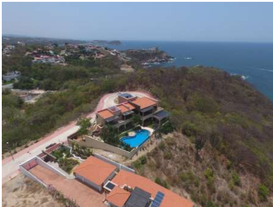
Construcción colindante al sitio del proyecto
