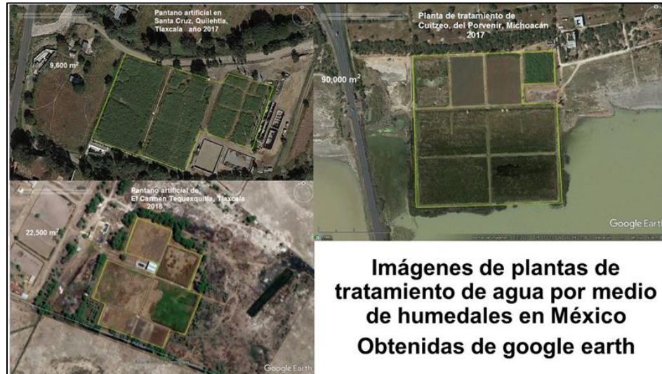
Figura 29. -Imágenes de los sistemas de tratamiento de agua por medio de humedales en México. Obtenidas de Google Earth.
