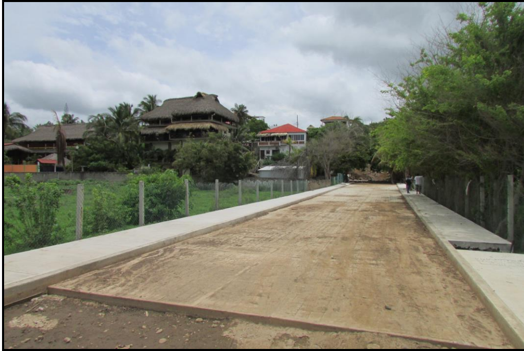
Fotografía 2. Colindancia Norte del polígono del proyecto con la calle Azucenas, nótese que la zona ya se encuentra urbanizada y con los servicios básicos.
