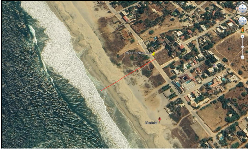
Fotografía 8. Visita del sitio del proyecto en relación con la zona federal marítimo terrestre del Océano Pacífico.
