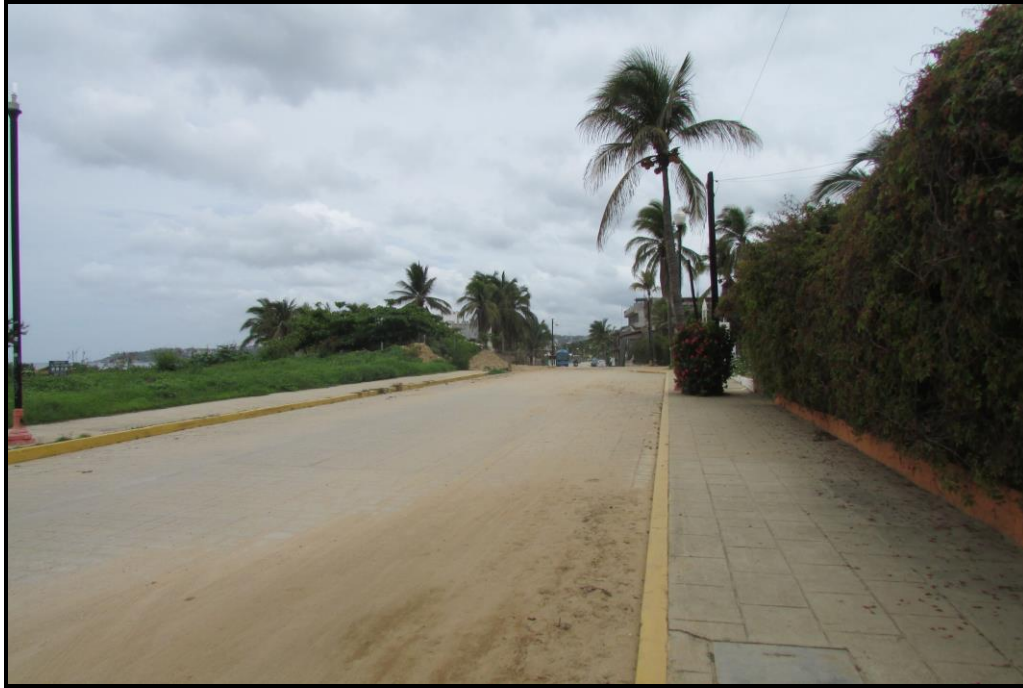
Fotografía 6. Colindancia poniente del sitio del proyecto.
