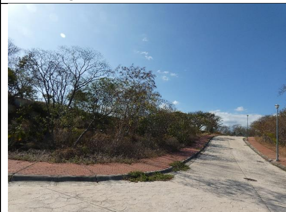
Se observan calles bien definidas y pavimentadas, alumbrado publico. Del lado izquierdo de la foto se observa el predio del proyecto,
