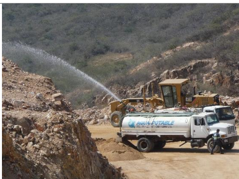
Ejemplo de riego en frentes de trabajo.
