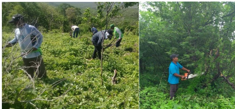
Ejemplo de desmonte con herramienta manual.
