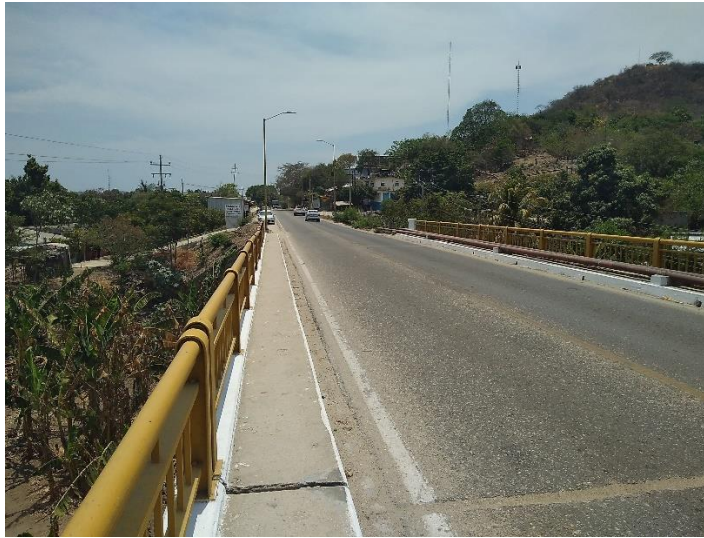
Puente sobre la Carretera Federal 200 aguas arriba del banco de extracción
