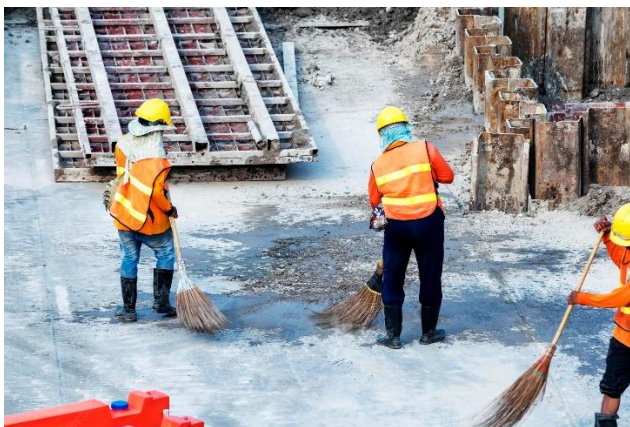
Ejemplo de limpieza que se efectuará en el sitio.
